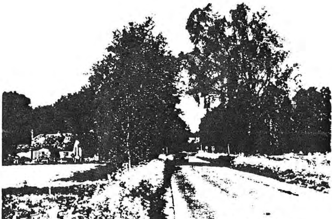
De Garderbroekerweg vanuit het zuiden gezien richting kruispunt Blotekamperweg.
