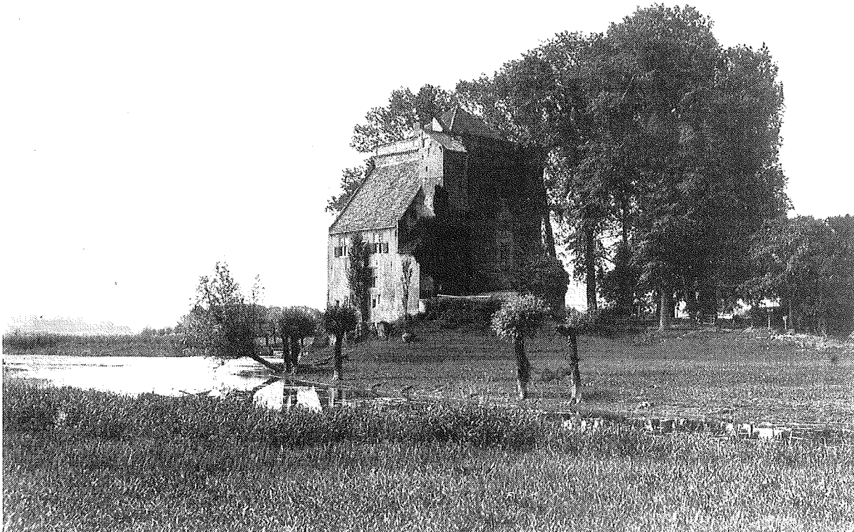
Kasteel Nijenbeek aan de IJssel, gem. Voorst. Opname van voor de Tweede Wereldoorlog toen het dak van het kasteel ten gevolge van oorlogshandelingen zwaar beschadigd raakte.
