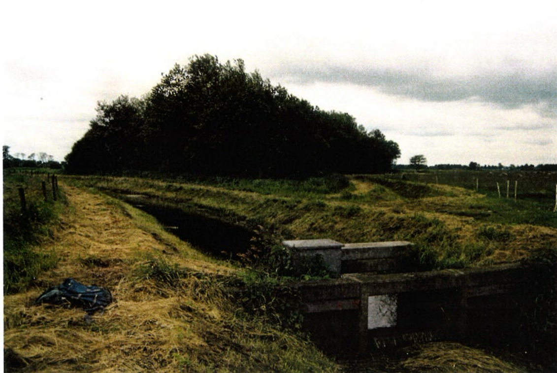
Foto 1. Het Witterdiep met nabijgelegen jong loofbosje
