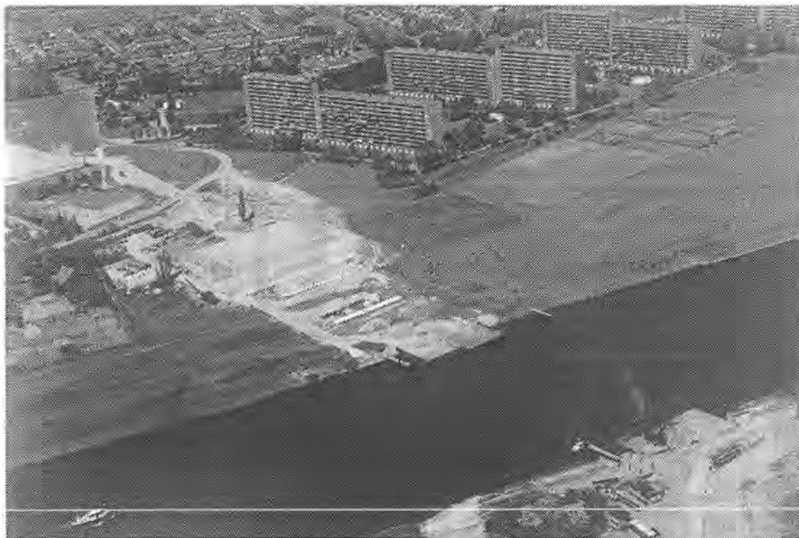
de aanleg van de Zuiderbrug (Zuiderbrugtracé) is reeds in volle gang
