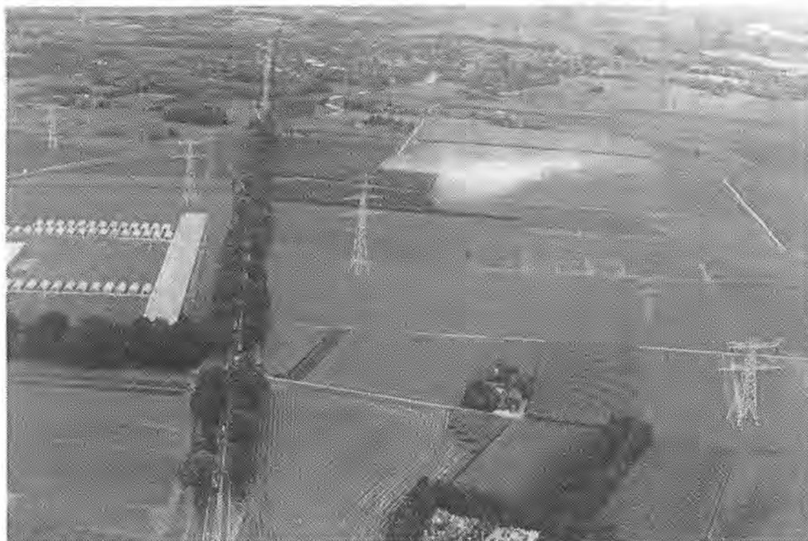
bij Nunhem wordt de N273 gekruist door een hoogspanningsleiding
