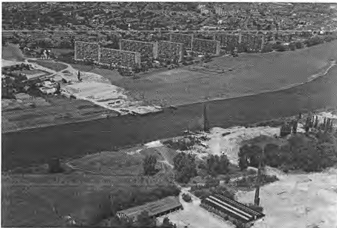
de Zuiderbrug in aanleg, op de achtergrond Tegelen.
