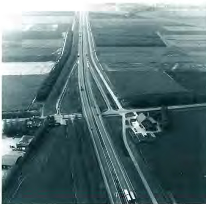
Aansluiting A17 Moerdijk
