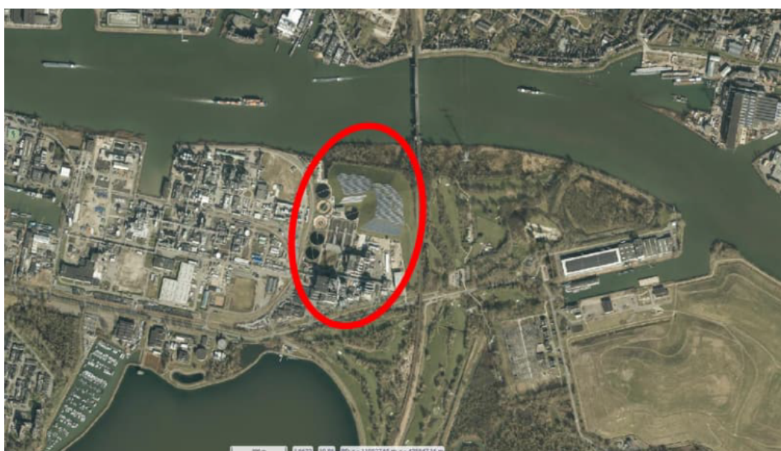
Figuur 1 Afvalenergiecentrale HVC te Dordrecht (Bron: NRD)
