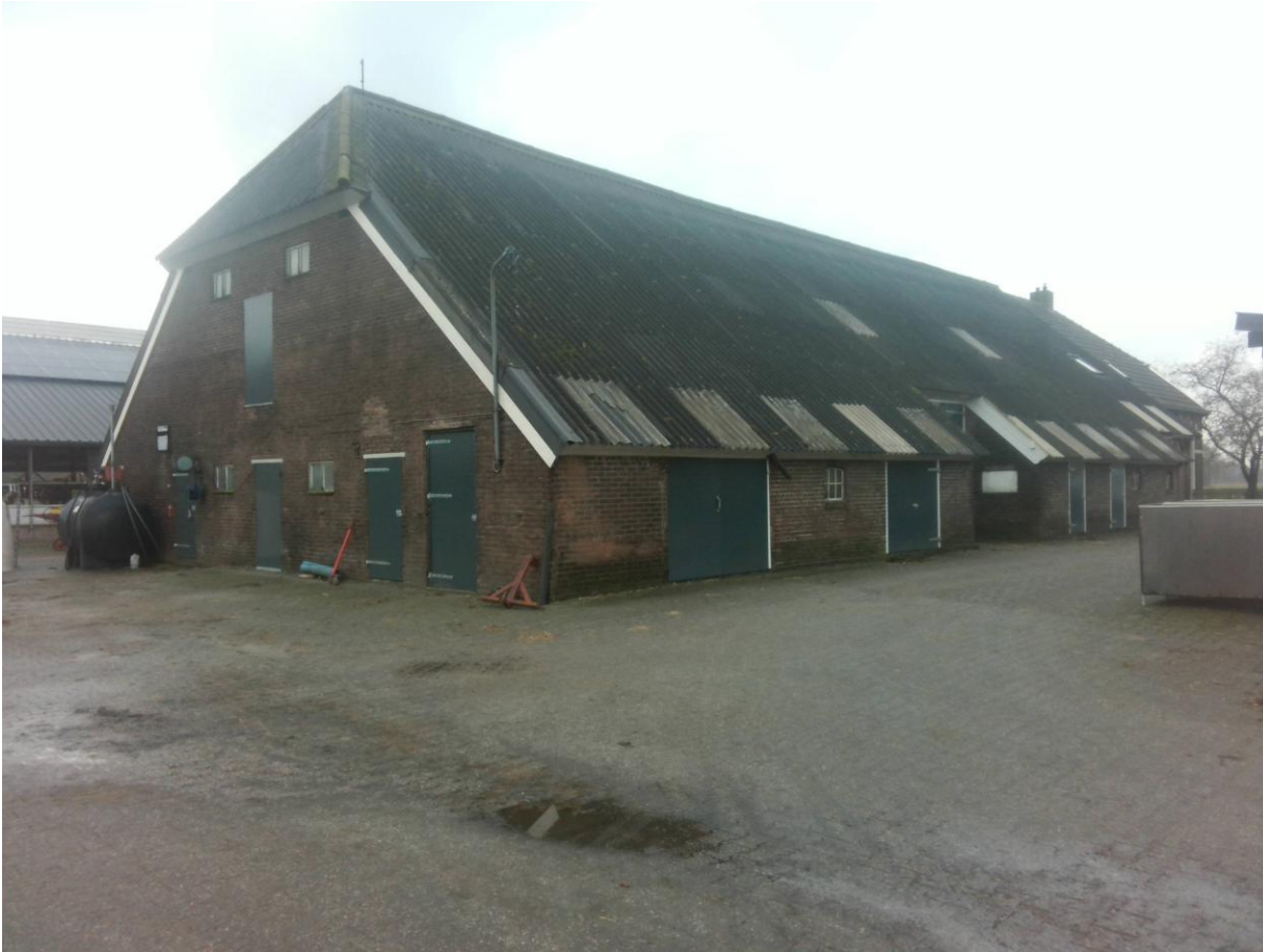
foto 1: achter zijde schuur aan woning_20241202_123919.jpg
