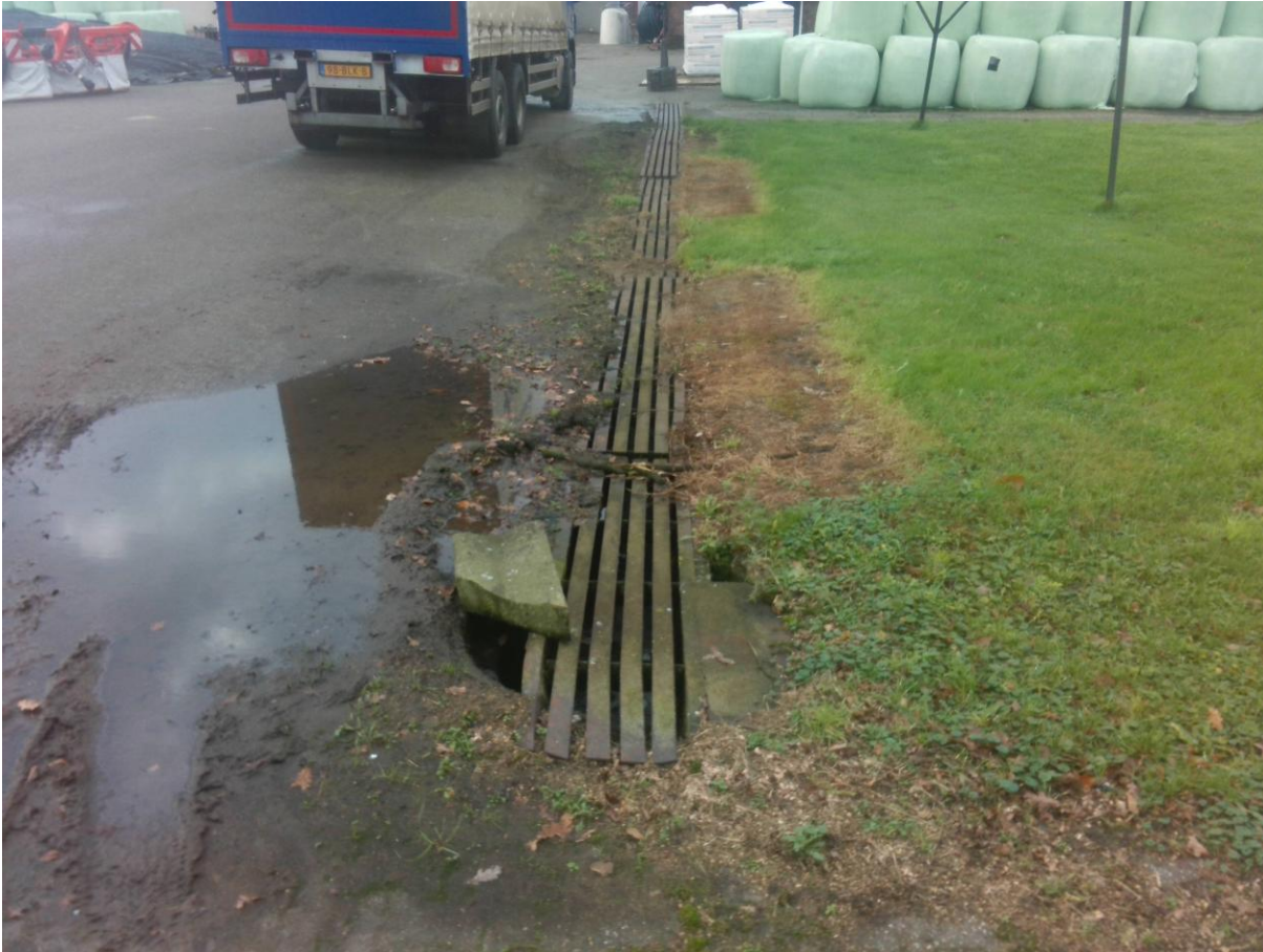
foto 10: afvoer links naast kapschuur_20241202_123611.jpg
