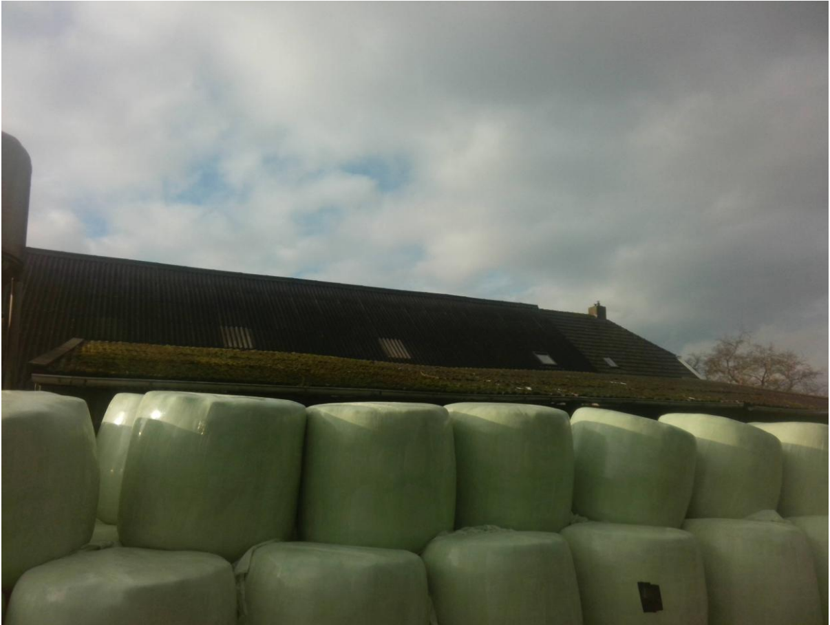
foto 21: kapschuur links direct naast woning_20241202_122411.jpg
