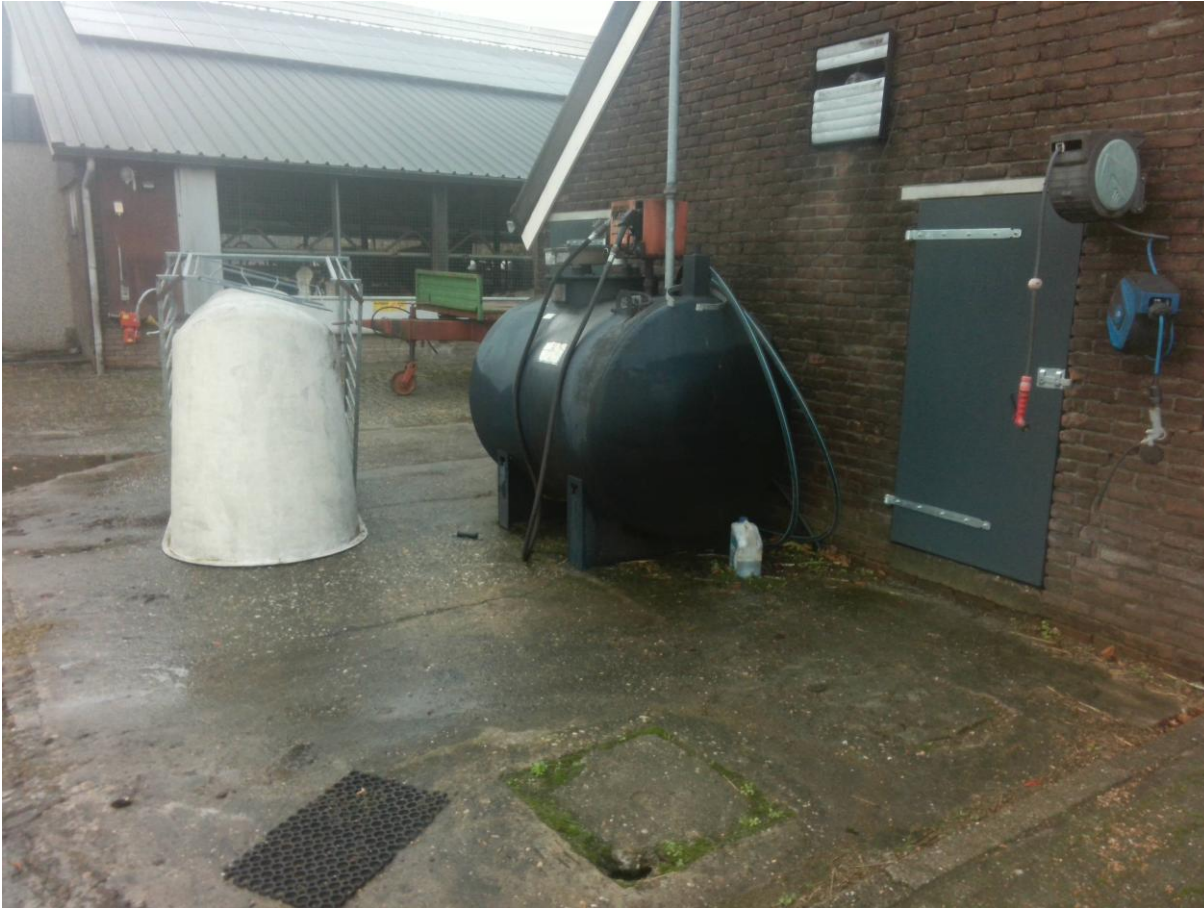
foto 2: achter zijde schuur aan woning_20241202_123940.jpg
