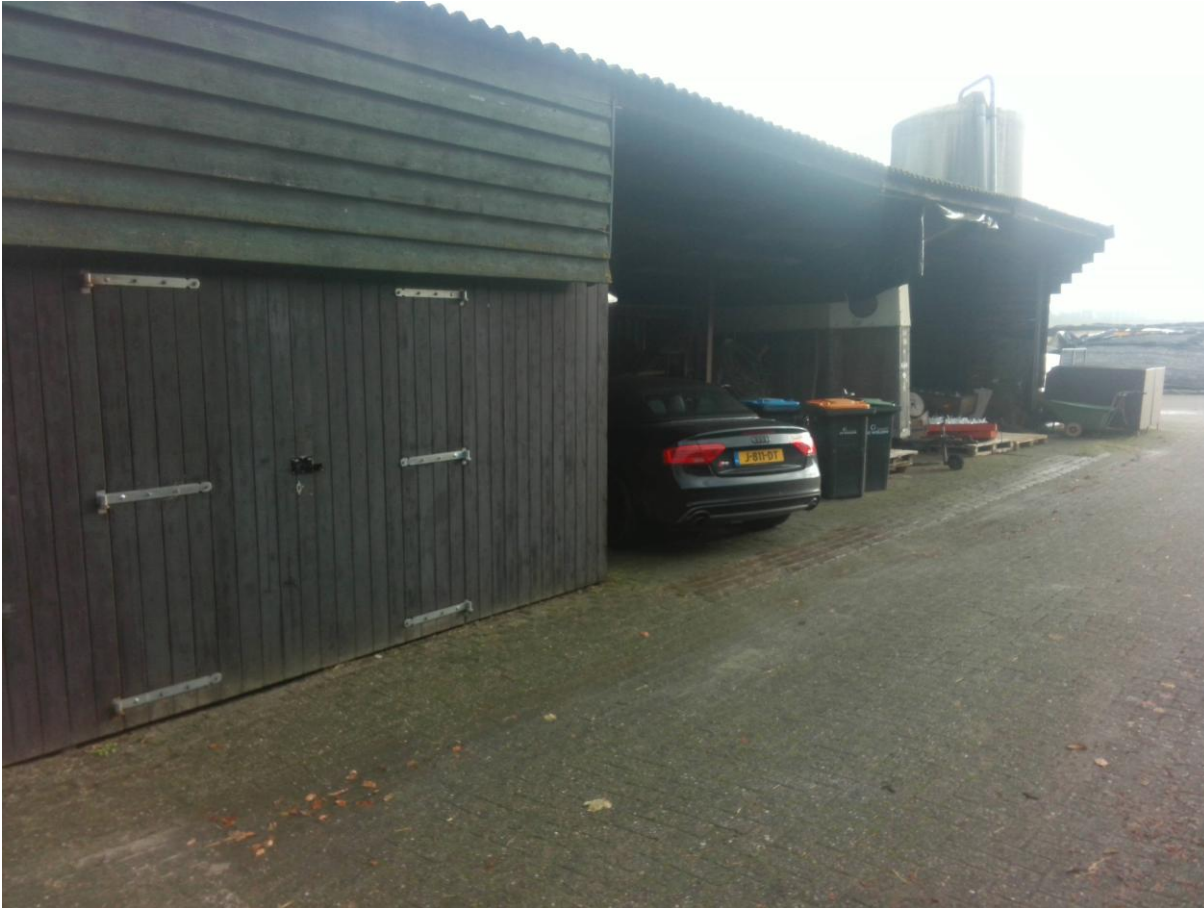
foto 18: kapschuur links direct naast woning_20241202_122240.jpg
