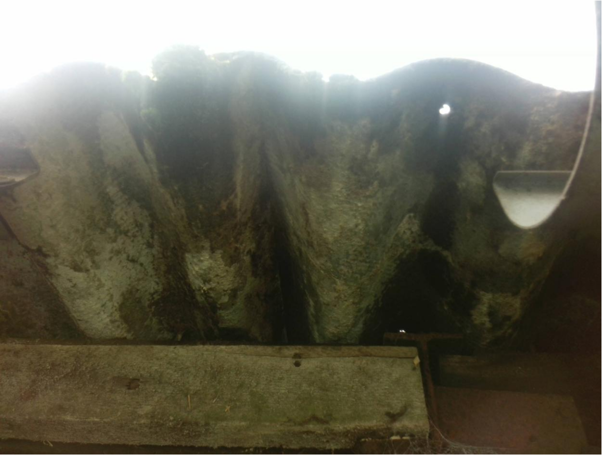
foto 22: kapschuur links direct naast woning_20241202_122501.jpg
