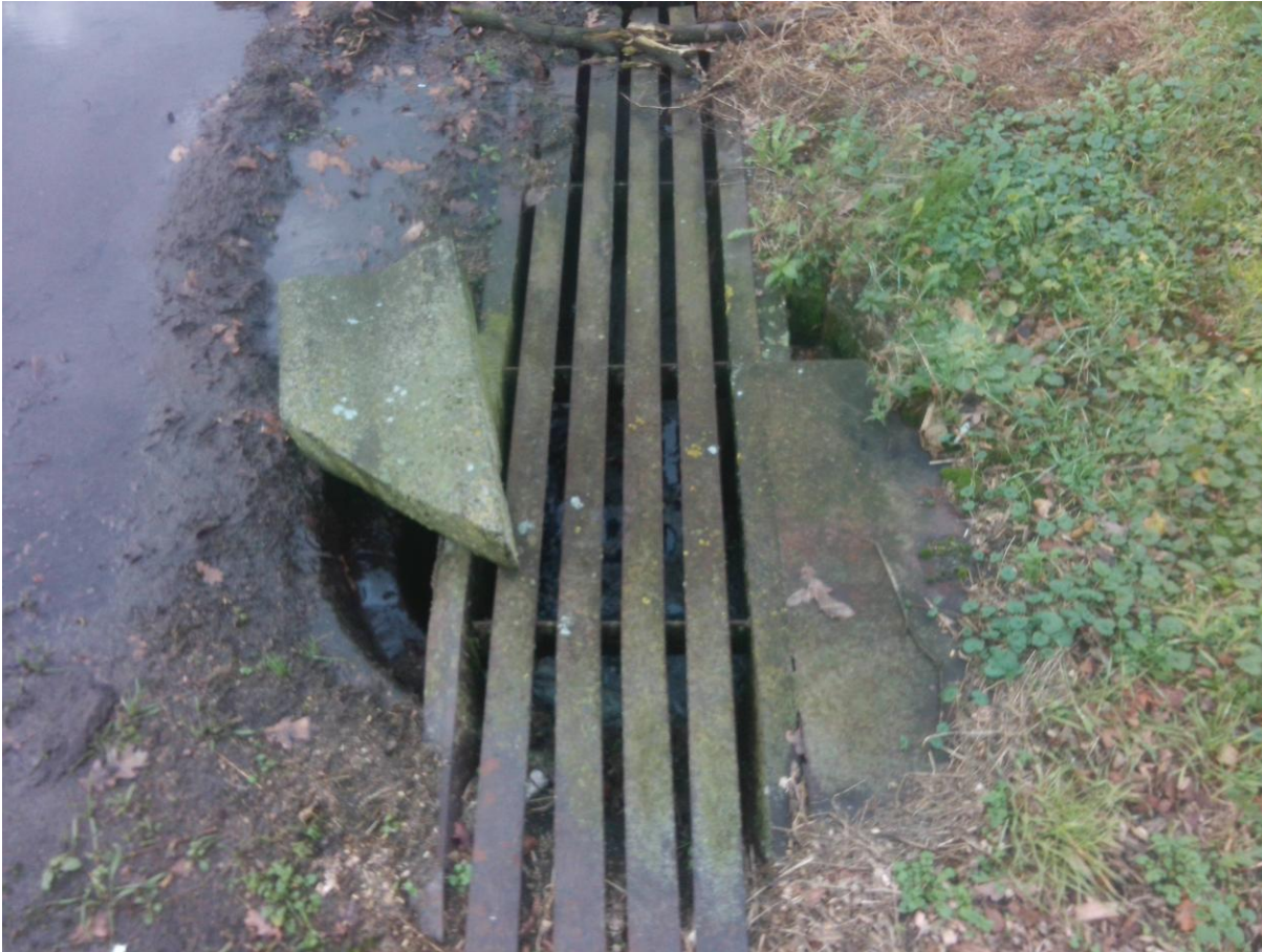
foto 11: afvoer links naast kapschuur_20241202_123619.jpg
