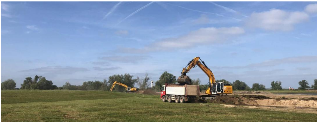
Foto 1 Voorbeeld droge winning, verwijderen toplaag (bron: Dekker Groep, 2024)
