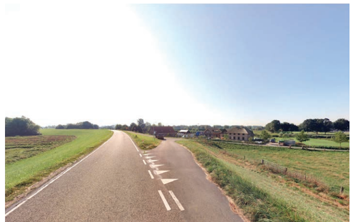
▲ Typische op-afritten van de dijk
