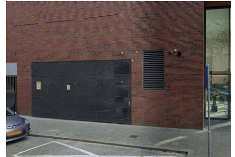
Afbeelding 140: een in de bebouwing of in een Darling geïntegreerde transformator heeft de voorkeur.
