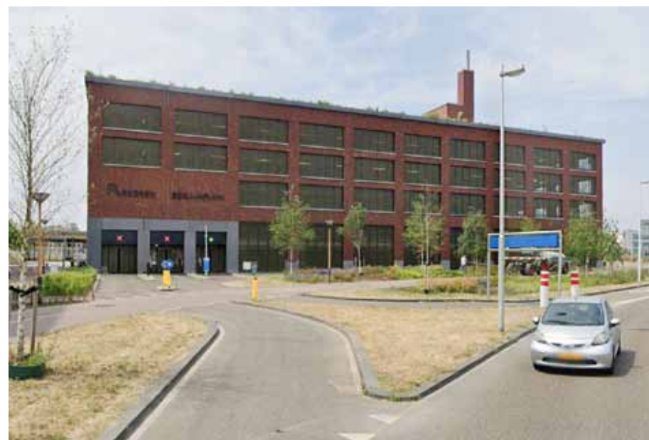
Afbeelding 136: parkeergarage Berlijnplein, Utrecht Zecc architecten
