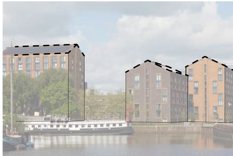
Afbeelding 125: integratie van installaties in het daksilhouet (Studentenhuysvesting Zwolle, De Zwarte Hond)
