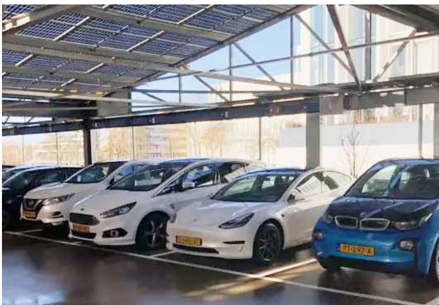
Afbeelding 135: parkeergarage met kapvorm en geïntegreerde zonnepanelen: parkeergarage A.S.R Vastgoed Utrecht
