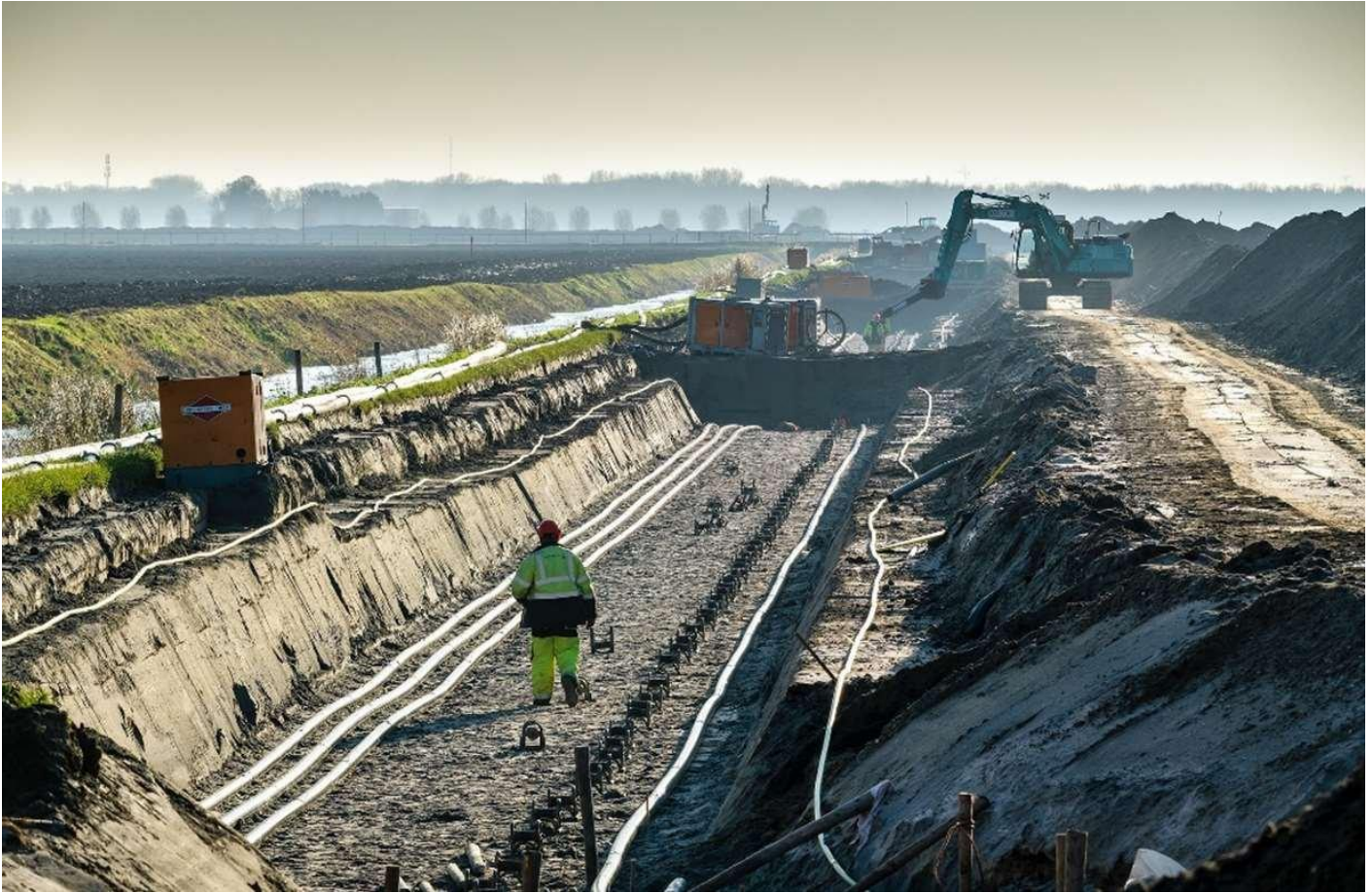
Figuur 2.2 Voorbeeld open ontgraving
