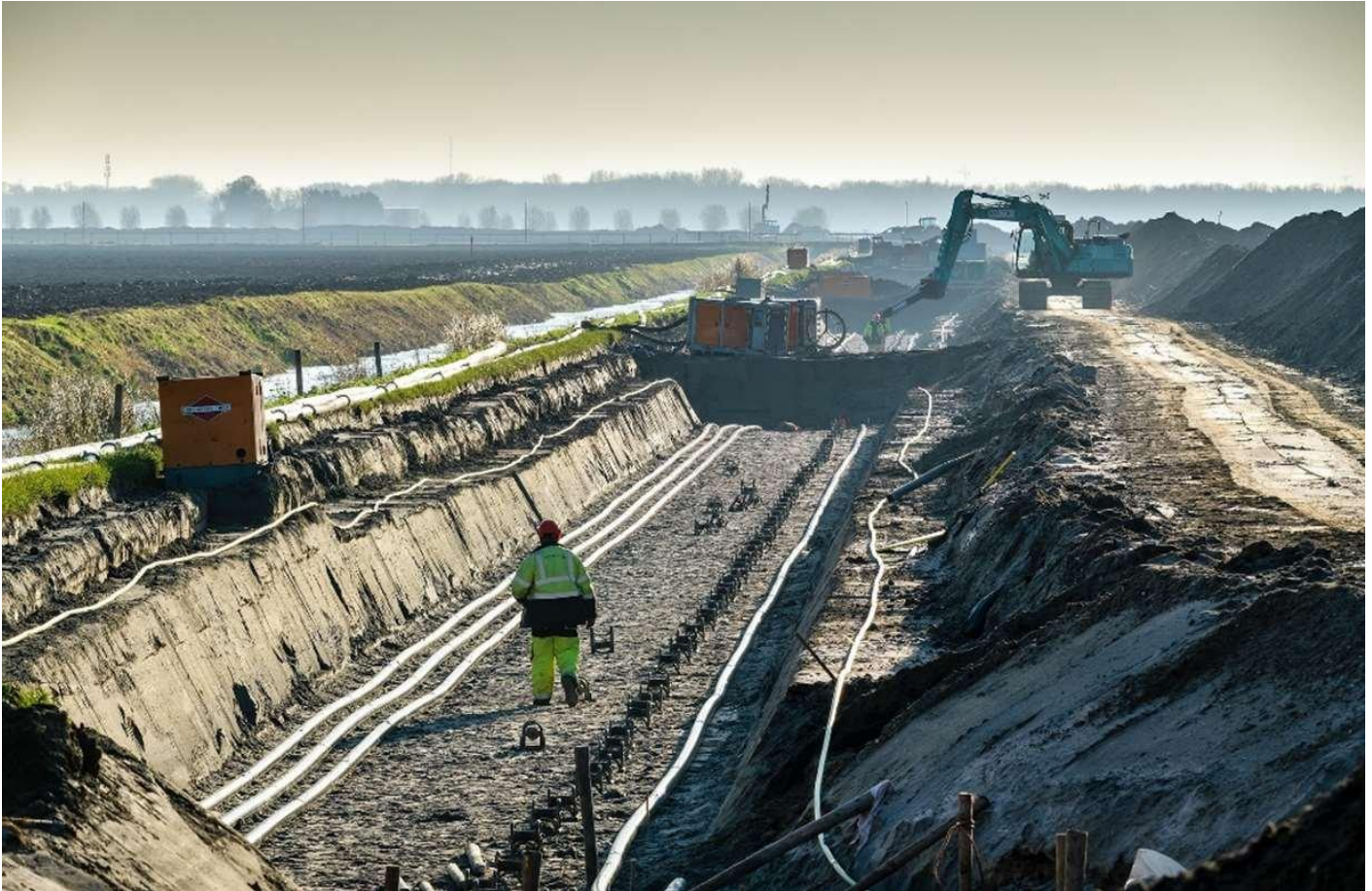
Figuur 2-7. Voorbeeld open ontgraving.
