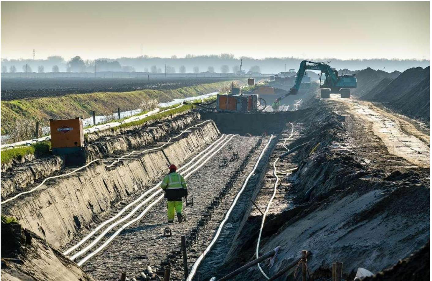
Figuur 5. Voorbeeld open ontgraving.
