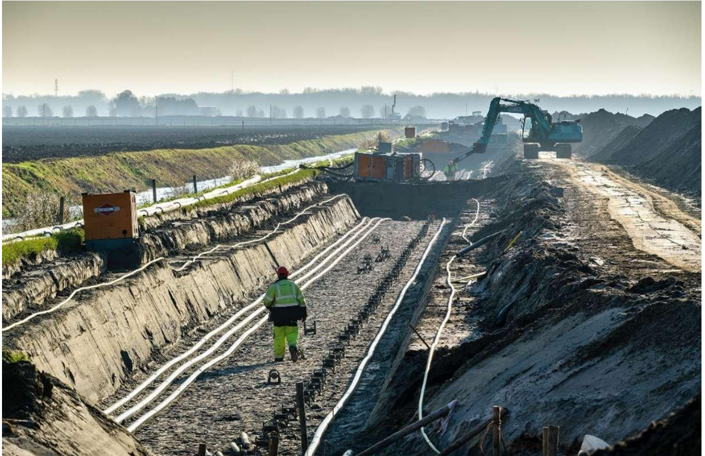
Figuur 5. Voorbeeld open ontgraving.
