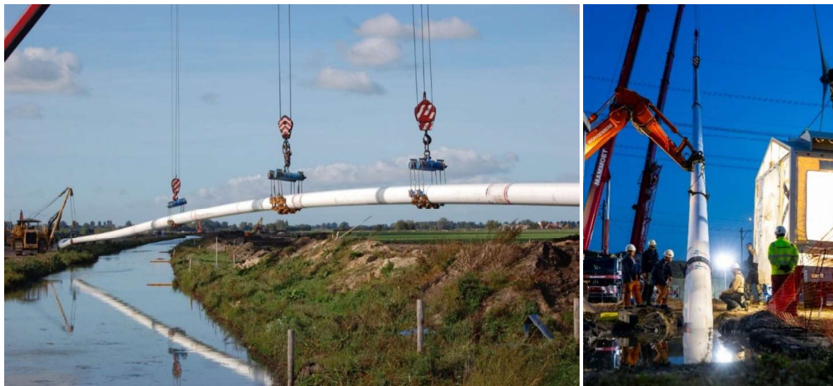
Figuur 4 links foto van een leiding die klaarligt voor een gestuurde boring. Rechts foto van een leiding die een boorgang in wordt getrokken.
