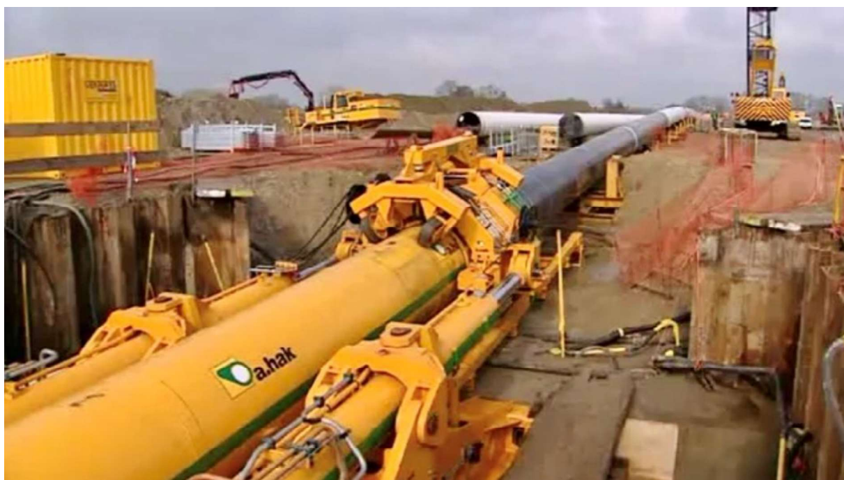
Figuur 5 Pijpleiding met de direct pipe techniek
