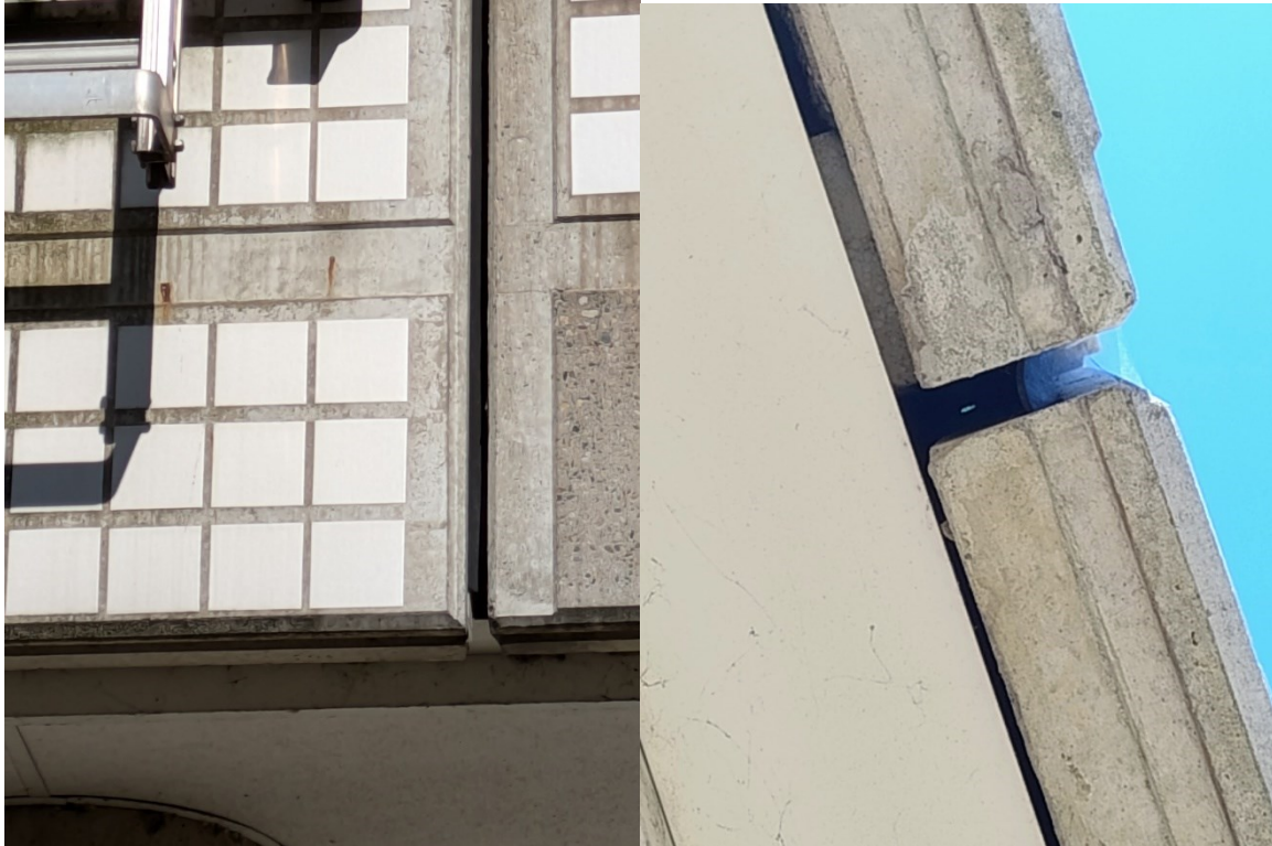
Afbeelding 4.2 Potentiële verblijfplaatsen voor gebouwbewonende vleermuizen in gebouwen sp, sf, sh en sb: gevelplaten
