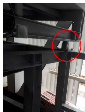
figuur 2 - vulblokken in opstelling t.b.v. achteraf invoegen trillingsisolatoren
