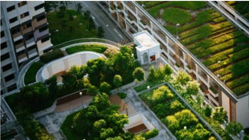
Intensieve groendaken (Zandcompleet)
