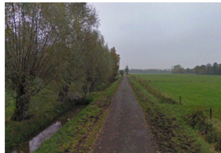
Rechte ruilverkavelingsweg Het Volmeer in het beekdal van de Essche Stroom. Parallel links van de weg is de nieuwe dijk aangelegd (foto Google Streetview).
