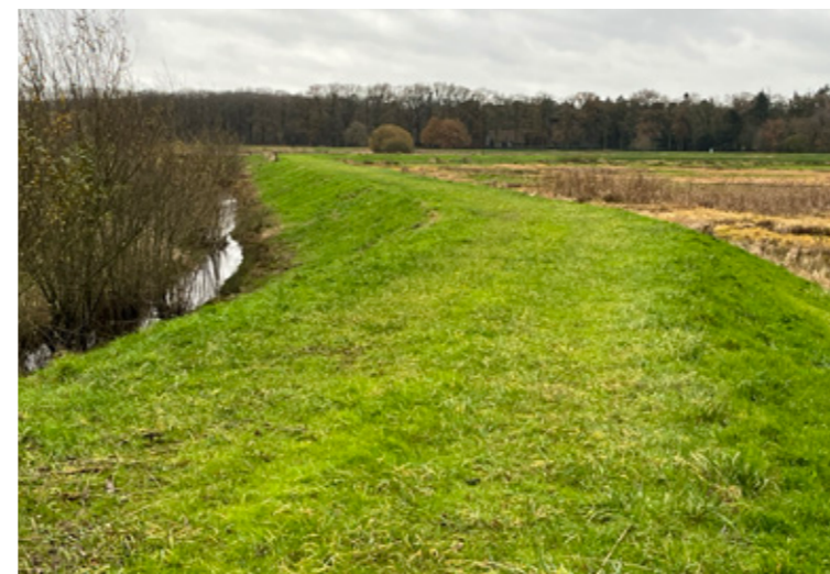
Nieuwe kade langs natuurgebied in het dal van de Essche Stroom.
