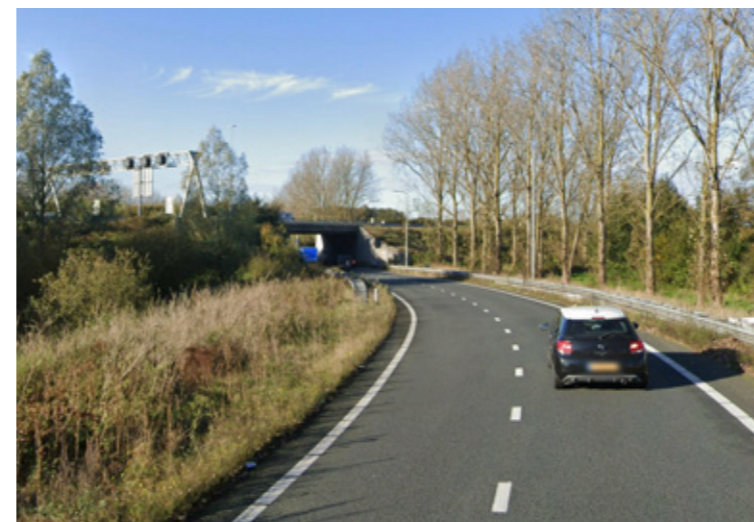
De onderdoorgang van de A2 is een lek in de waterkering via randweg Vught (foto Google Streetview).
