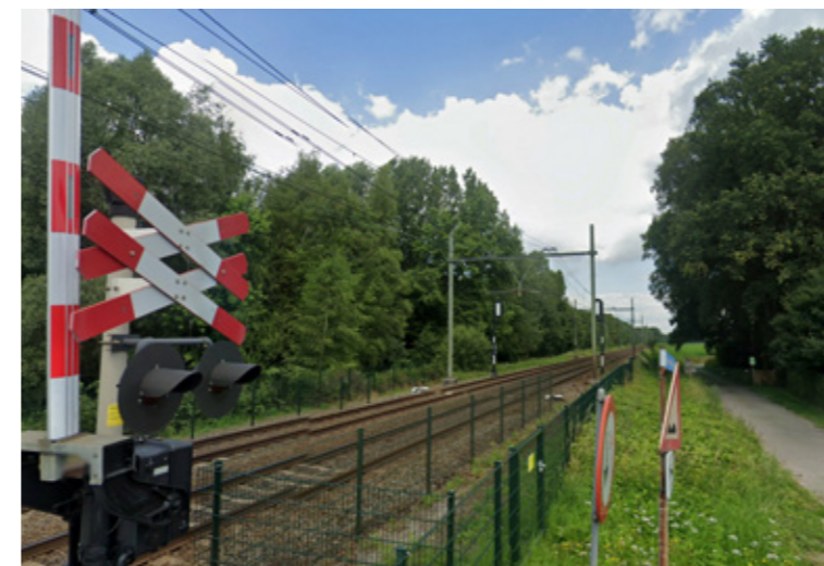
Spoordijk bij de kruising van Halsebroek/Groensteeg, kijkend in noordelijke richting.
