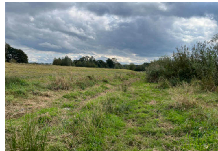
Nieuwe 'calamiteitendijk' in het beekdal van de Essche Stroom.
