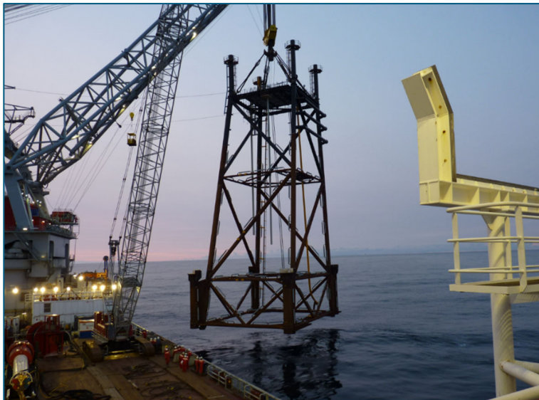
Figuur 2-2: Plaatsing van een onderbouw.
