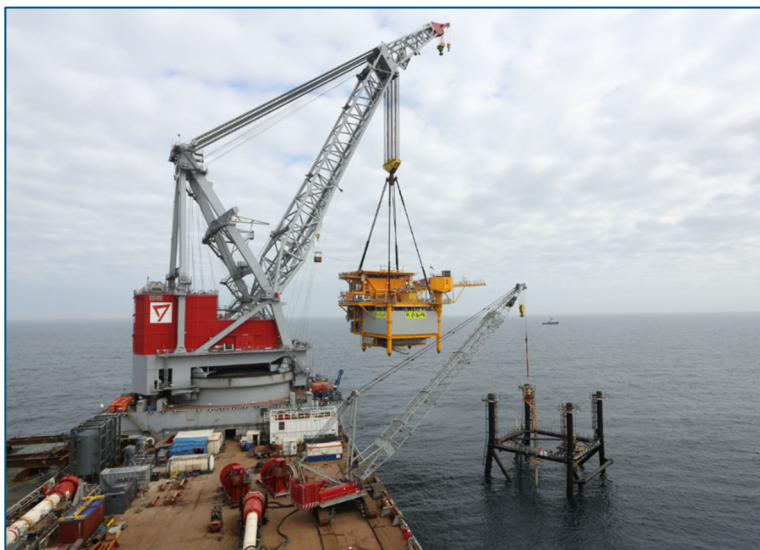
Figuur 2-3: Plaatsing van een bovenbouw op een onderbouw.
