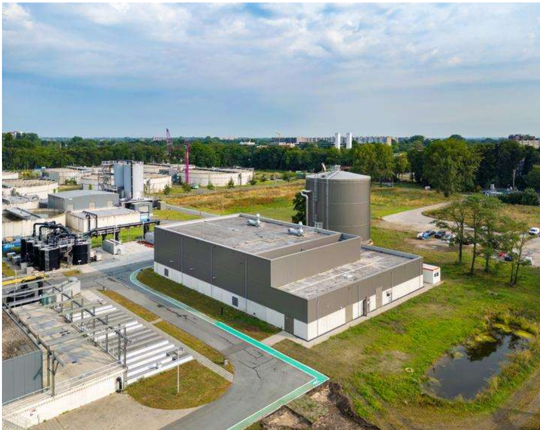
Figuur 4.17 Aquathermie Rioolwaterzuivering Utrecht (bron: Eneco https://www.eneco.nl/over-ons/wat-we-doen/duurzame-bronnen/warmte/warmtepomp-rwzi-utrecht/ )
