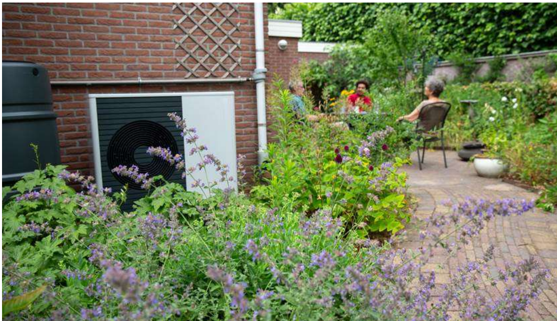
Figuur 4.11 Buitenunit van een individuele lucht-water warmtepomp. (bron: Milieu Centraal:
