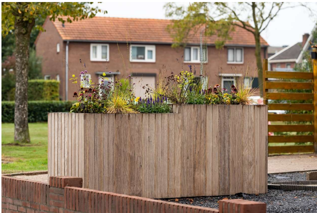
Figuur 5.2 Warmtepomp Flowerbox (bron: https://www.vanwijnen.nl/nieuws/aardgasvrij-maken-woning-met-op-maat-gemaakte-flowerbox )
