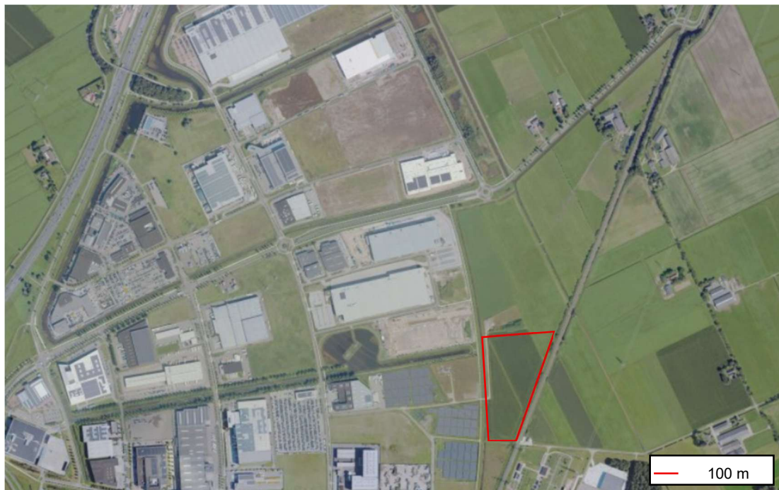
Figuur 4.1 Bovenaanzicht Hessenpoort (bron: Street Smart Cyclomedia)
