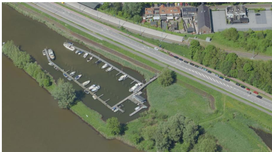
Figuur 2-2: Jachthaven WSV IJsselmuiden aan deeltraject 6.2
