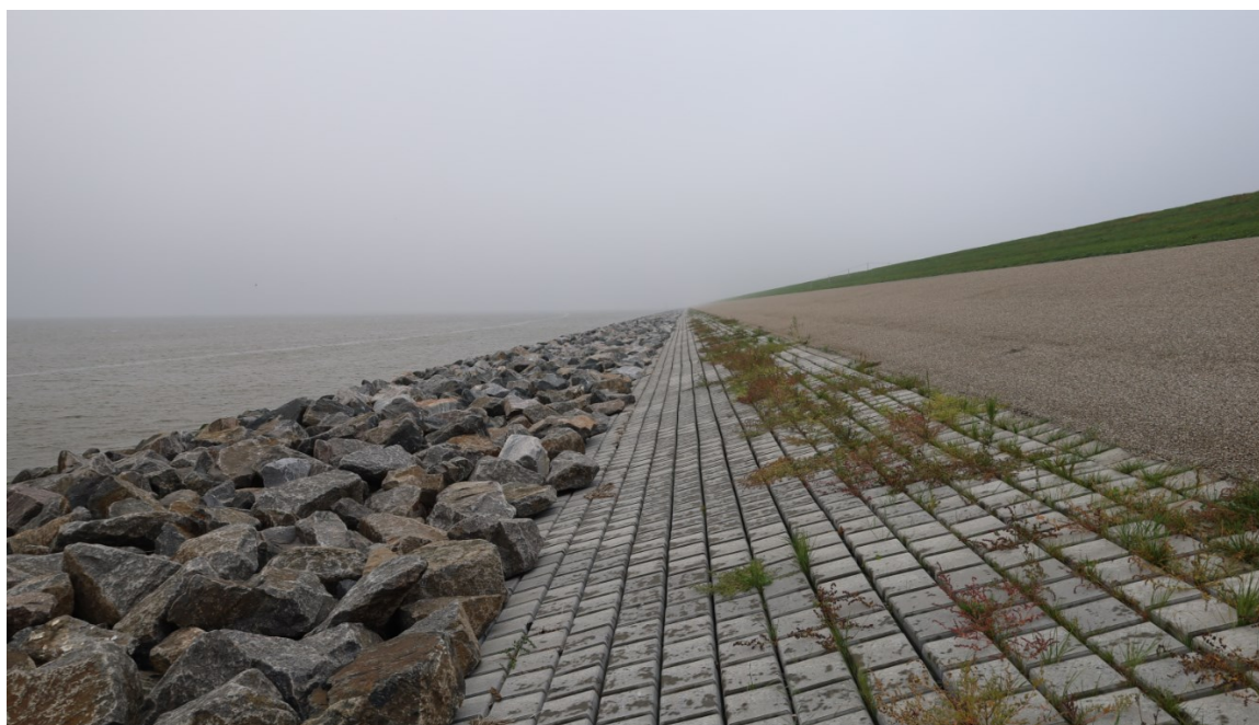
Afbeelding 5.7 Impressie teenconstructie van breuksteen (foto dijkversterking Lauwersmeerdijk-Vierhuizergat)
