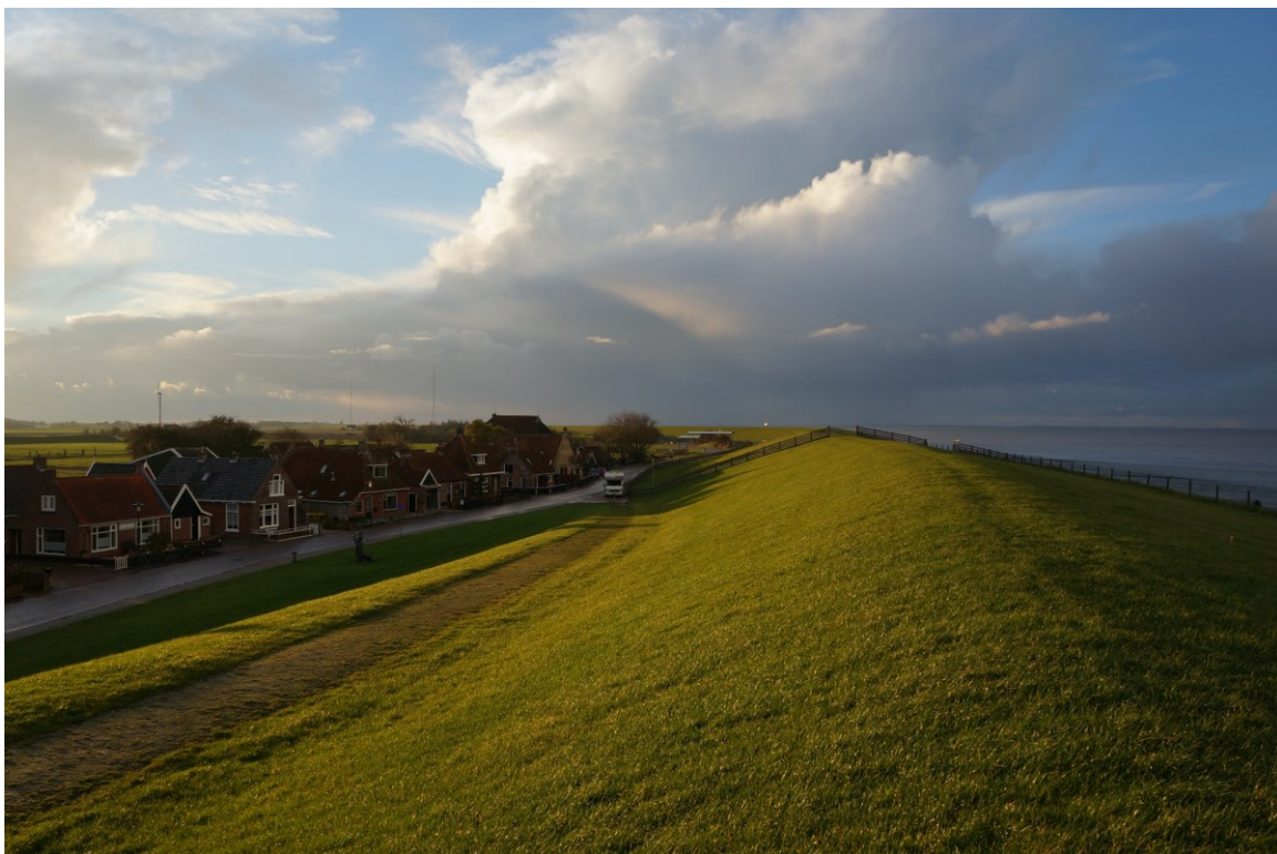
Afbeelding 2.11 Dijk in deeltraject Peazens-Moddergat (richting het noorden)
