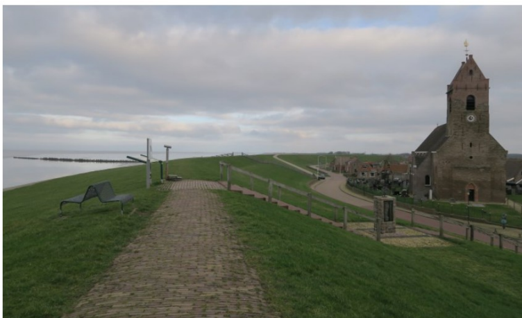
Afbeelding 2.12 Dijk in deeltraject Wierum dorp (richting het oosten)
