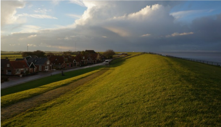
Afbeelding 2.17 Dijk in deeltraject Peazens-Moddergat (richting het noorden)
