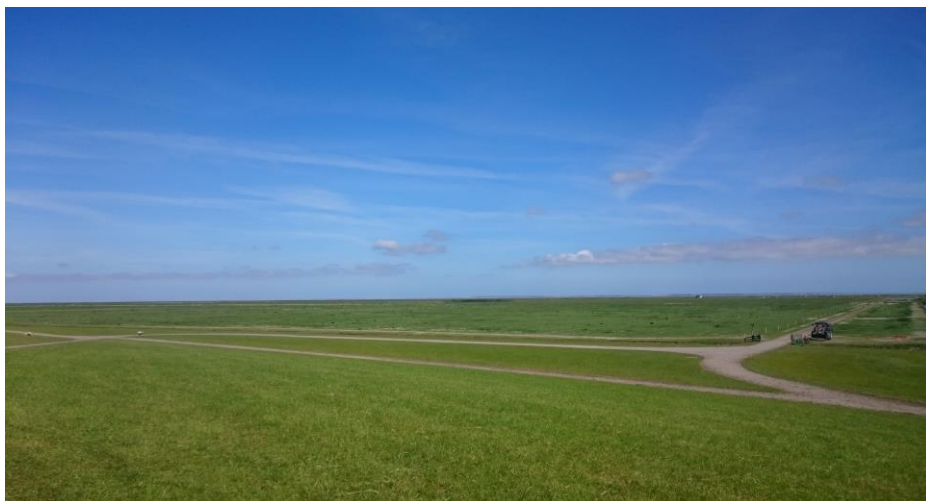
Afbeelding 3.14 Buitendijkse zijde dijk, deelgebied 3
