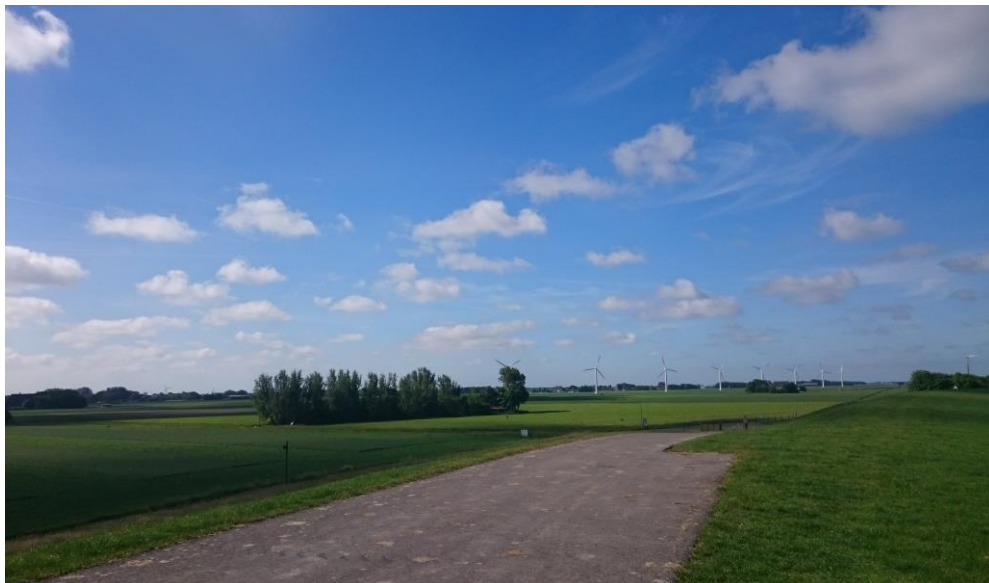
Afbeelding 3.13 Binnenzijde dijk, deelgebied 3
