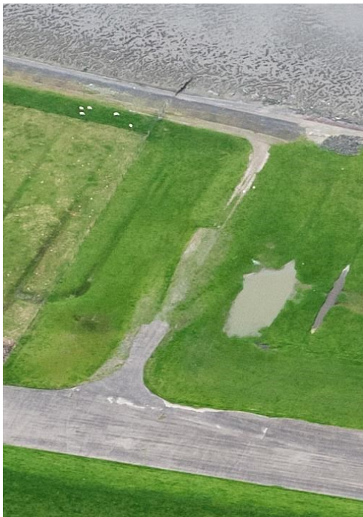
Afbeelding 3.3 De locatie waar de voorlanddam wordt aangelegd
