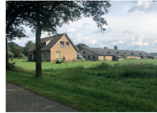
Landschappelijke elementen ontbreken momenteel op locatie Molenakker 3. Gebouwen staan kaal in het landschap en onderscheid tussen erf en naast gelegen weilanden is niet zichtbaar.
