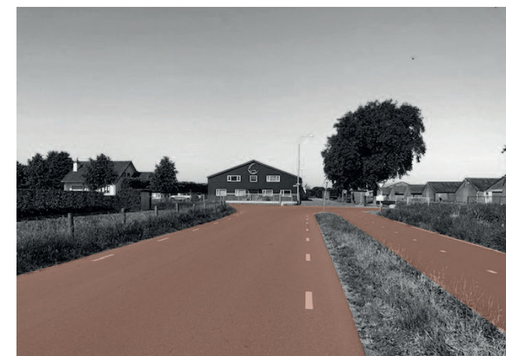
Afbeelding 18, Huidige toegangsweg vanaf Volkelseweg heeft momenteel een functionele maar heeft een stenige uitstaling door het ontbreken van beplanting.
