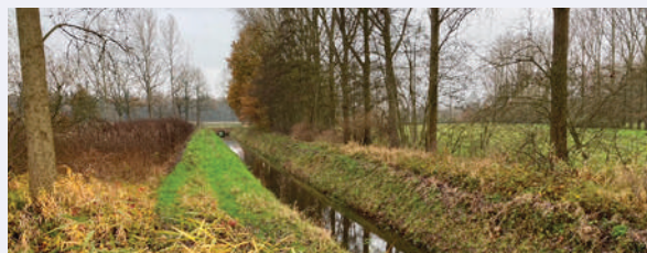
36 De duiker onder de Bossche Baan gezien vanaf Bossche broek zuid
