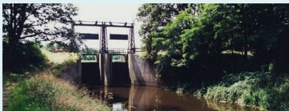
45 Bestaand sluisje aan het Drongelens Kanaal (fietspad) tegenover De Leij.
