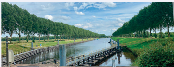
27 Het Diezekanaal, kijkend naar het oosten vanaf Sluis Engelen.
