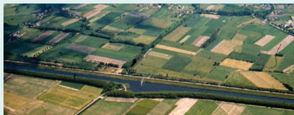
46 Het Drongelens Kanaal in 1970, kijkend naar het zuiden.
