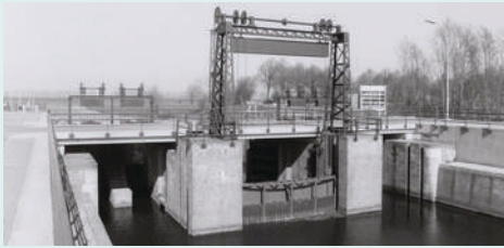
47 De Bovenlandse sluis (1991).
