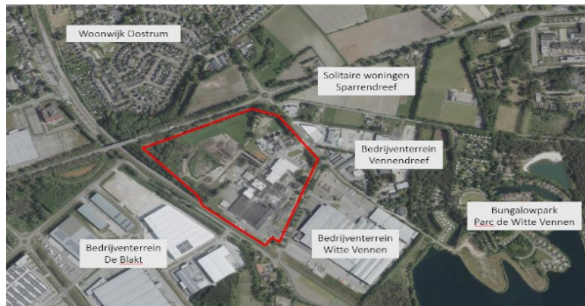
Figuur 4-3 Omliggende bedrijventerreinen
