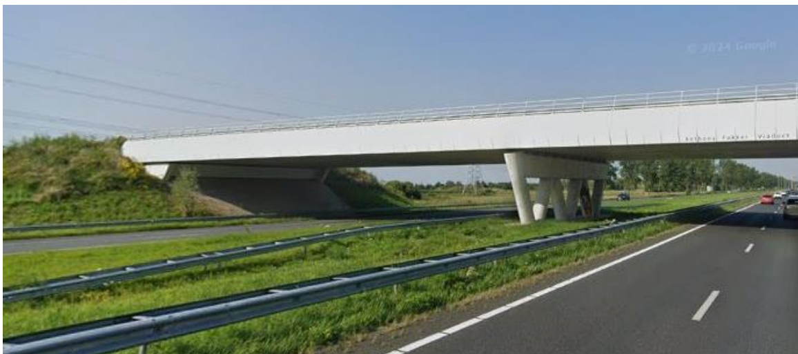
Afbeelding I.6 BM6 - Anthony Fokker Viaduct
