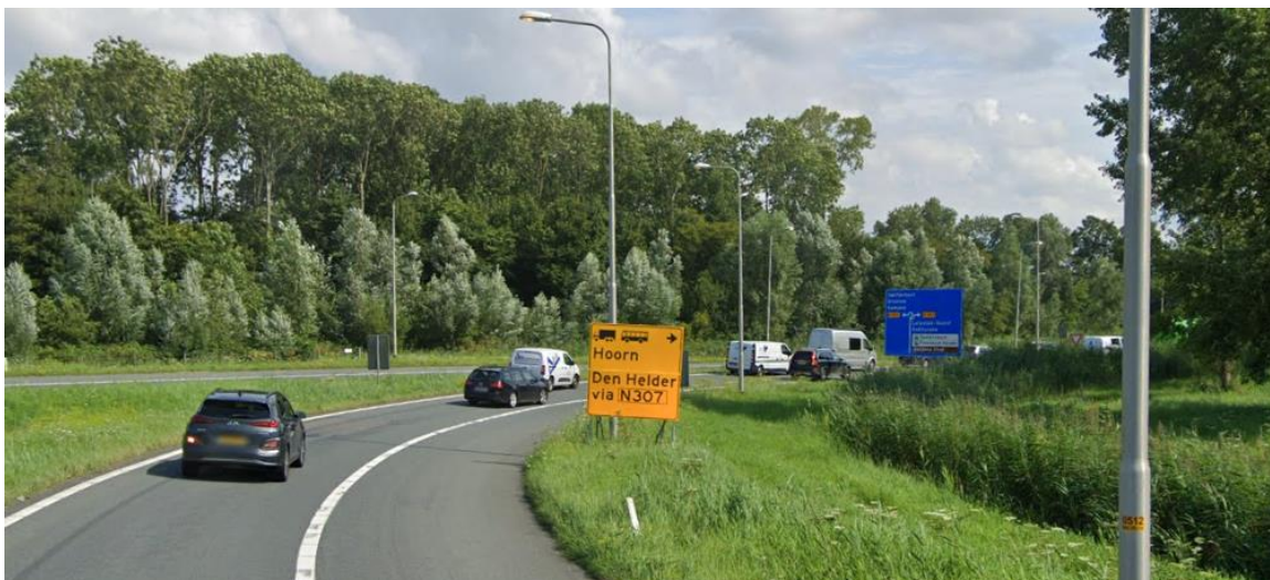
Afbeelding 3.2 Risico op onvoldoende anticipatiezicht door begroeiing in de berm bij de afrit van aansluiting 11
