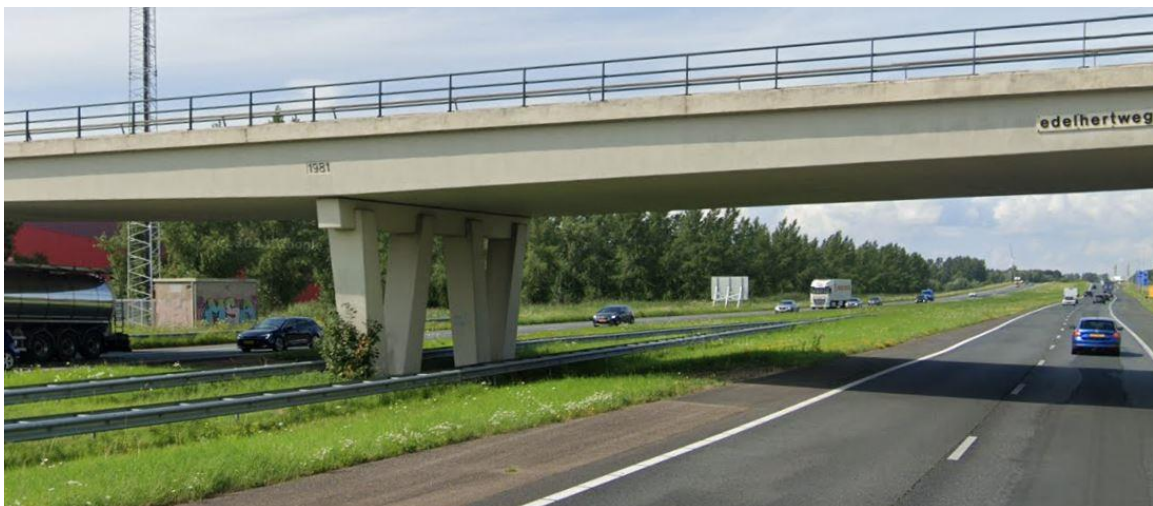
Afbeelding I.12 BM12 - viaduct Edelhertweg
