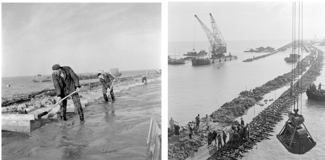
Afbeelding 21 Aanleg van de Knardijk 1955 (fotograaf: Freek Aal). Bron: Nederlands Fotomuseum, Collectie: De Waarheid. In de schaduw van de wederopbouw (FHA-776-1 en FHA-777-5) via http://www.geheugenvannederland.nl/ .
