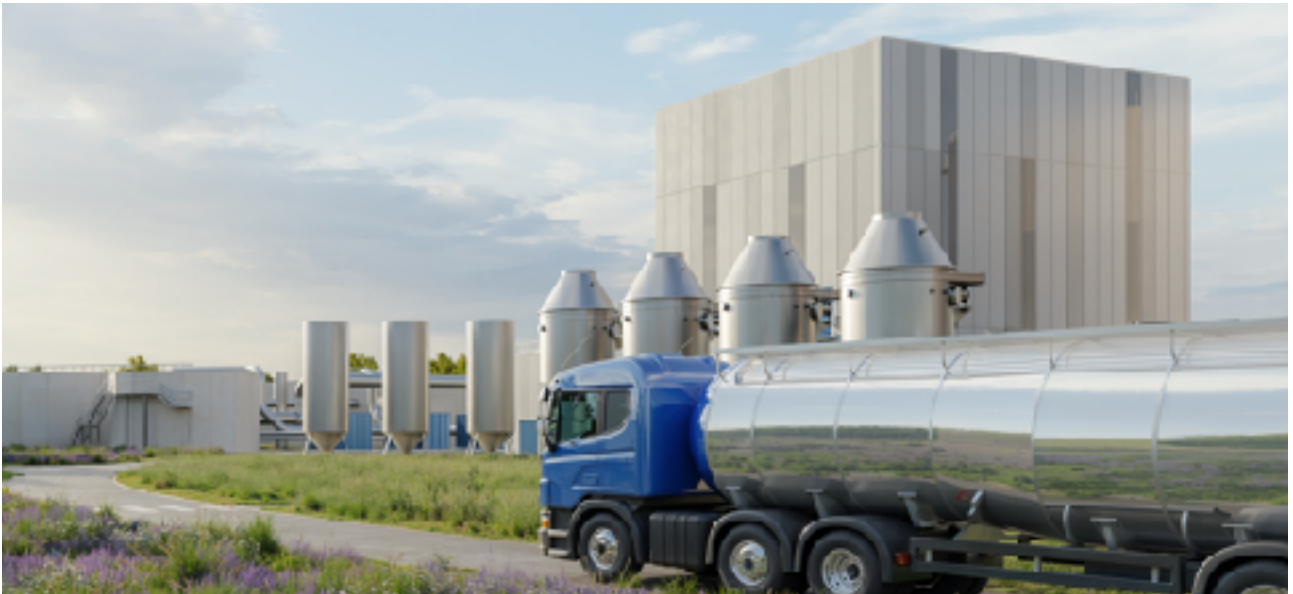
De gevel van het nieuwe slibverwerkingsgebouw met zachte contrasten
