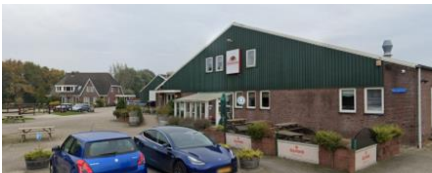
Afbeelding II.2 Foto van de woning met manege gelegen naast aanbrengvlak 4 voor het heien van funderingspalen
