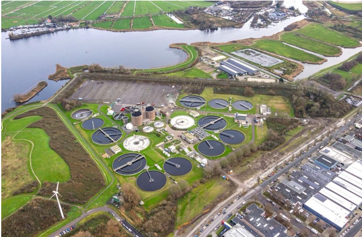
Foto bestaande situatie
