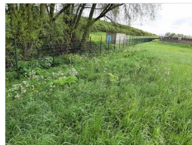
Figuur 2.8 Noordwestelijke rand van de AWZI, kijkrichting oost.
