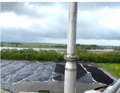
Figuur 2.9 Slibopslag AWZI, kijkrichting oost.
