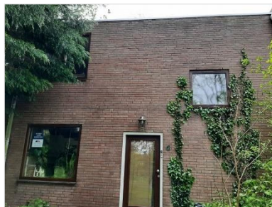
Figuur 2.13 Bedrijfswoning met smalle open stootvoegen in noordgevel.
