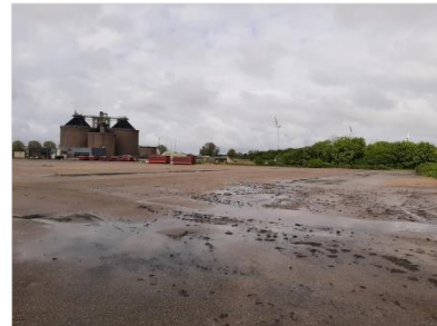
Figuur 2.5 Slibopslag (oostzijde) AWZI, kijkrichting noordwest.
