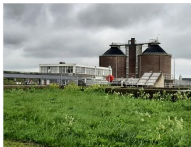
Figuur 2.7 Bedrijfsgebouw (kantoor) en slibvergistingstorens in het midden van de AWZI, kijkrichting noordoost.
