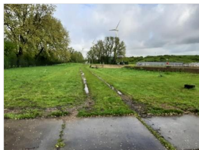
Figuur 2.3 Noordwestzijde AWZI, kijkrichting noord.
