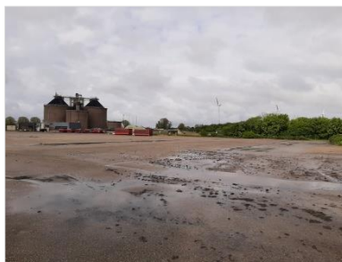
Figuur 2.5 Slibopslag (oostzijde) AWZI, kijkrichting noordwest.
