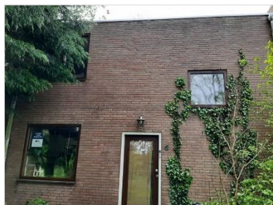
Figuur 2.13 Bedrijfswoning met smalle open stootvoegen in gevel.
