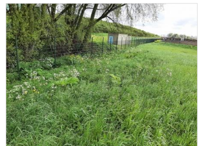
Figuur 2.9 Noordwestelijke rand van de AWZI, kijkrichting oost.
