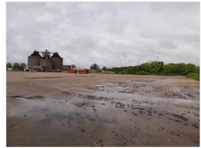
Figuur 2.6 Slibopslag (oostzijde) AWZI, kijkrichting noordwest.
