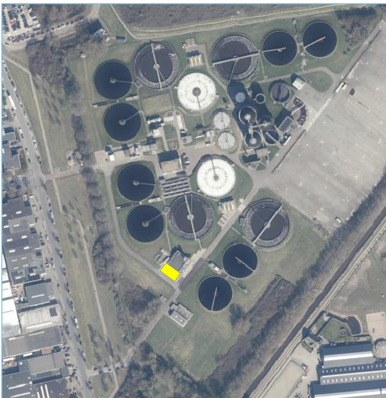
Figuur 7.4: Locatie tijdelijke slibontwateringsinstallaties (geel)
