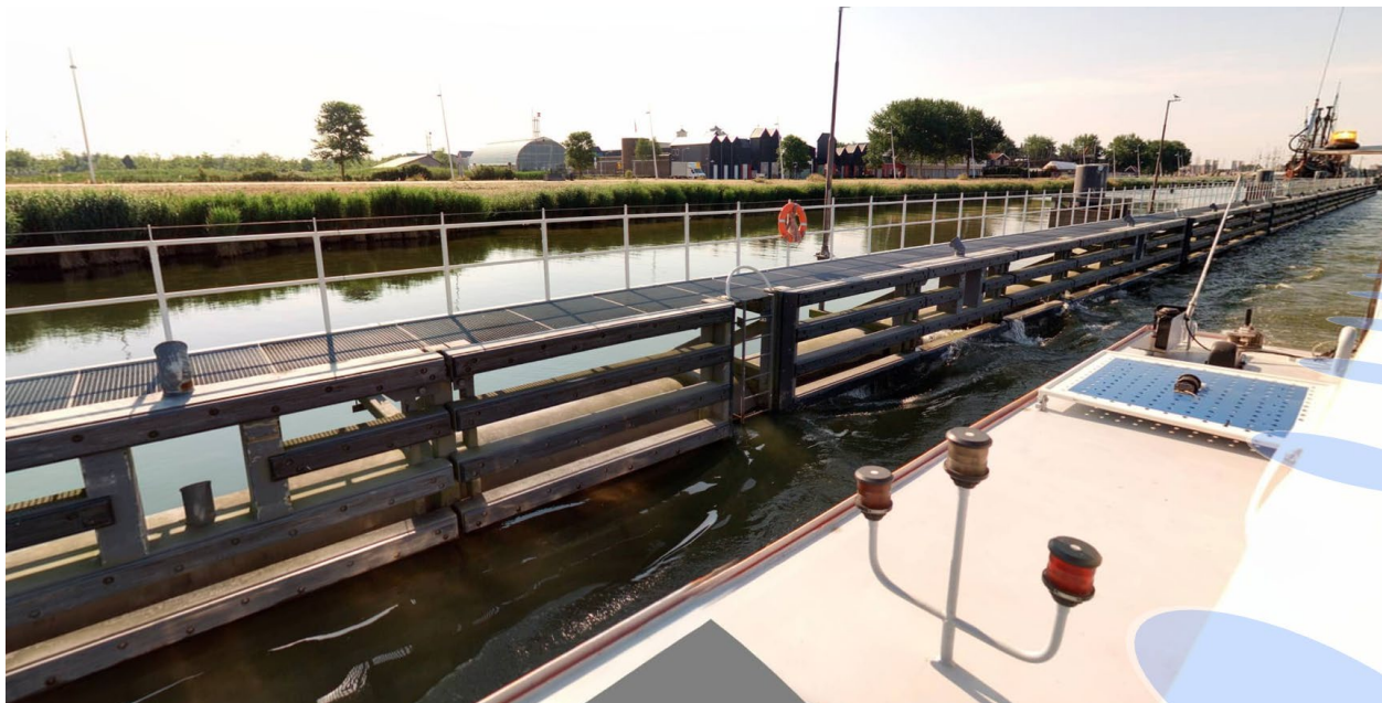
Figuur 2-2. Drijvende afmeervoorziening die nu voor Bataviakwartier ligt en verplaatst gaat worden.
