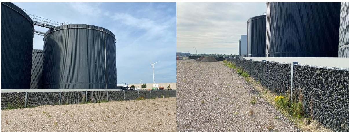
Afbeelding 4. De vergistingsinstallatie ten zuiden van de bouwkaavel (links) en de scheiding tussen de bestaande vergistingsinstallatie en de bouwkaavel (rechts).
