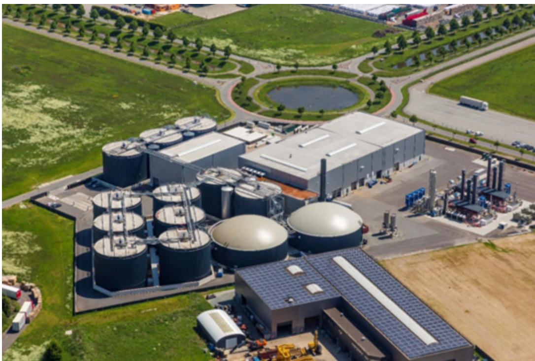
Figuur 1: Bestaande situatie vergistingsinstallatie BEC (bron: NRD).
