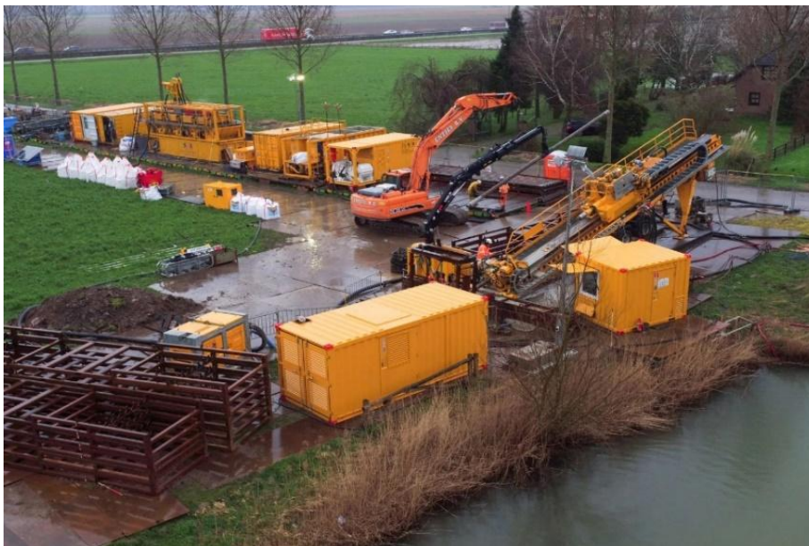
Figuur 3-3. Boorstelling voor de uitvoering van een horizontaal gestuurde boring (bron: Gasunie).
