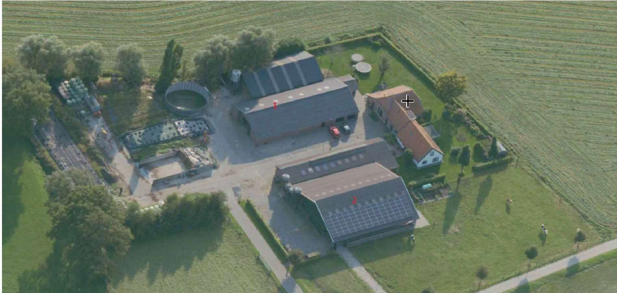
Luchtfoto locatie [redacted] september 2024. De stallen zijn aangeduid met een rode 1 en een rode 2.
