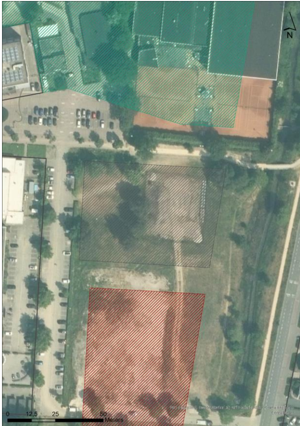
Afbeelding 2.7 Luchtfoto Parkeergarage Vlijtseweg
