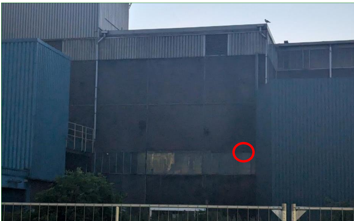
Twee zomerverblijven van Gewone dwergvleermuis aan de noordzijde (boven, rode omlijning) en zuidzijde (onder, rode cirkel) van het fabrieksgebouw in deelplot 03. De exacte verblijfplaats aan de noordzijde kon niet worden vastgesteld, de rode omlijning is een indicatie.
