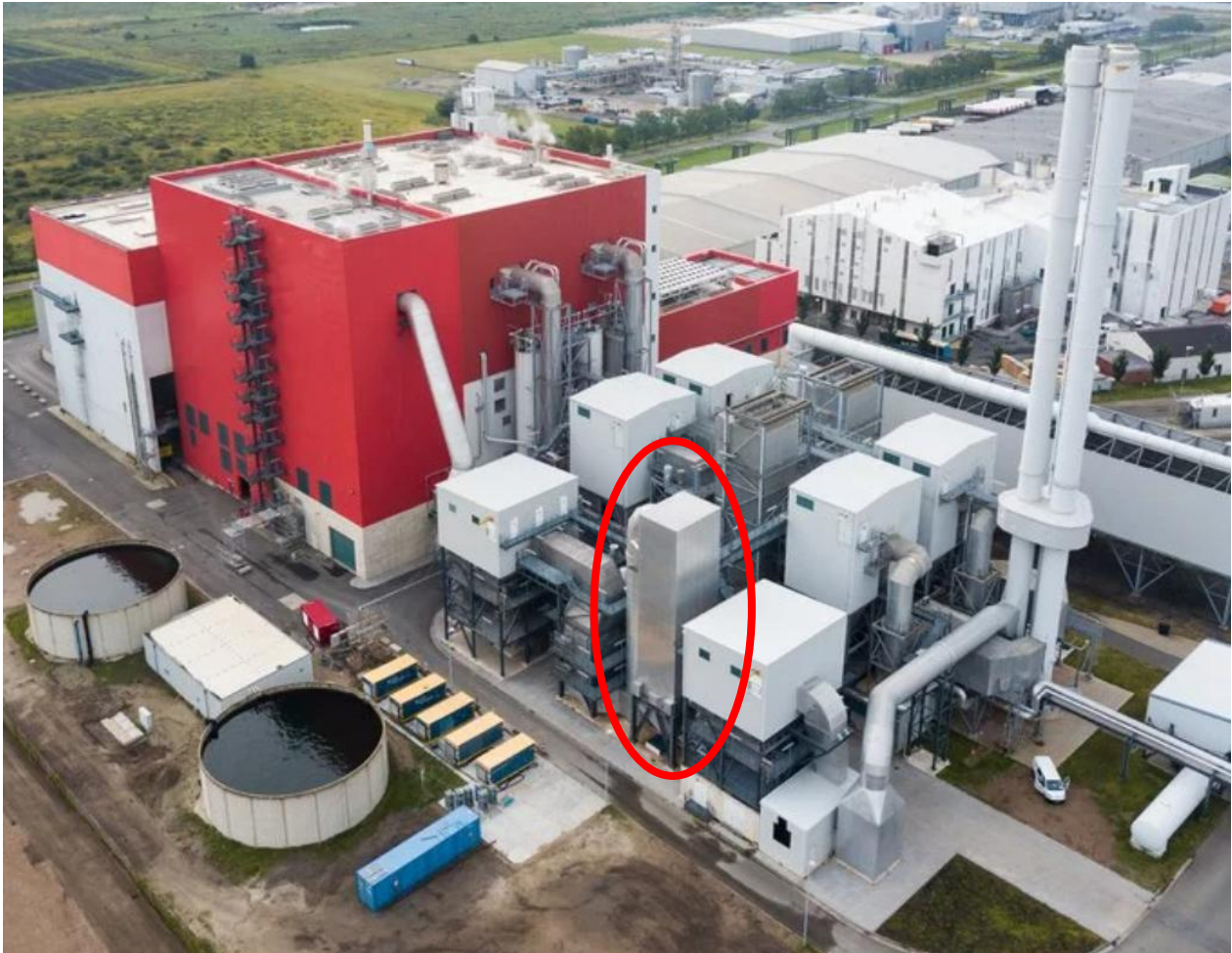
Figuur 5.13. Voorbeeld van een externe economizer en de daarvoor benodigde ruimte (EEW verbrandingslijn 3, 5,1 MW)
