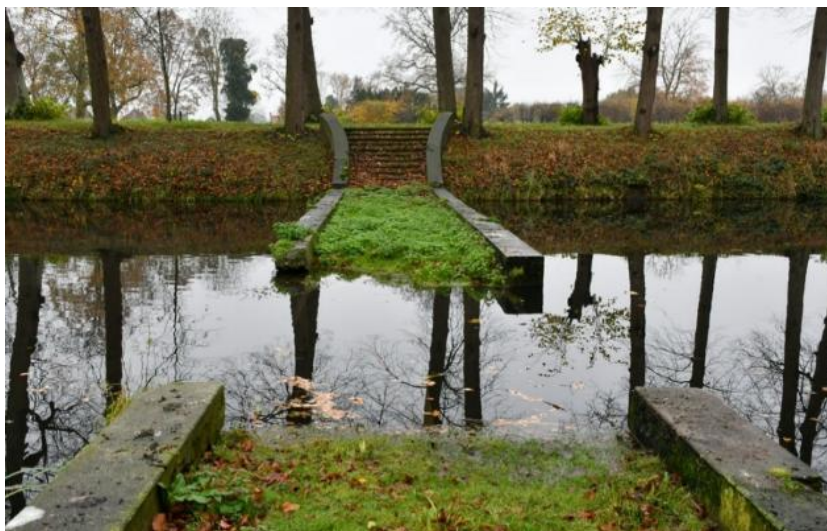
Figuur 4.25: Huidige betonnen verbinding over buitengracht
