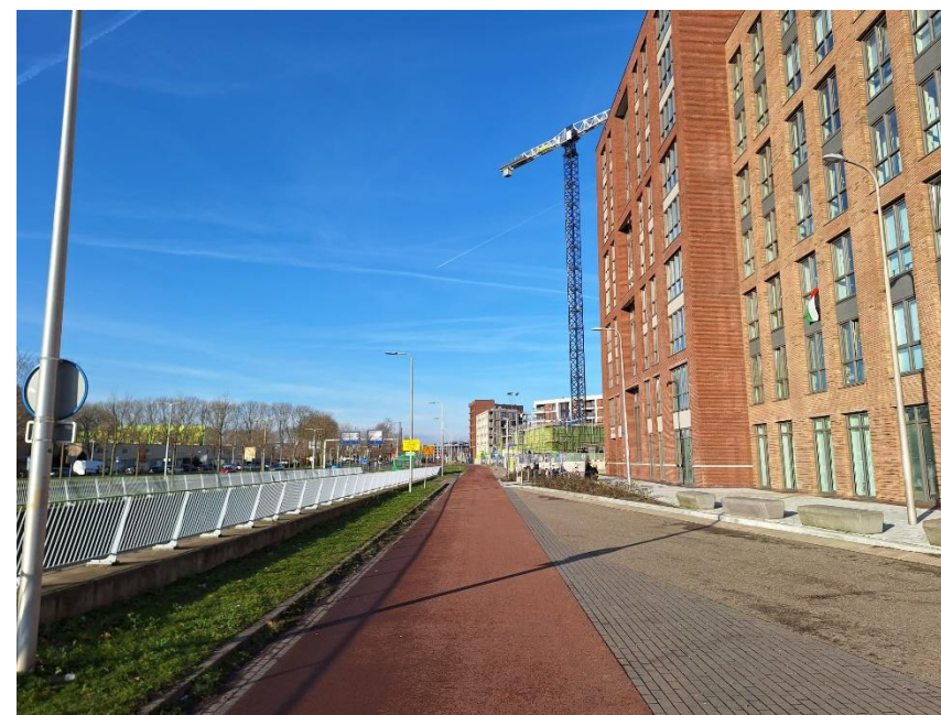
Figuur 5-4: Omgeving waarin de verdiepte ligging aangelegd dient te worden, tussen de busonderdoorgang (links) en de nieuwbouw (rechts) (bron: Mott MacDonald)
